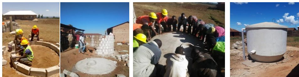
Bau des Regenwassertanks
